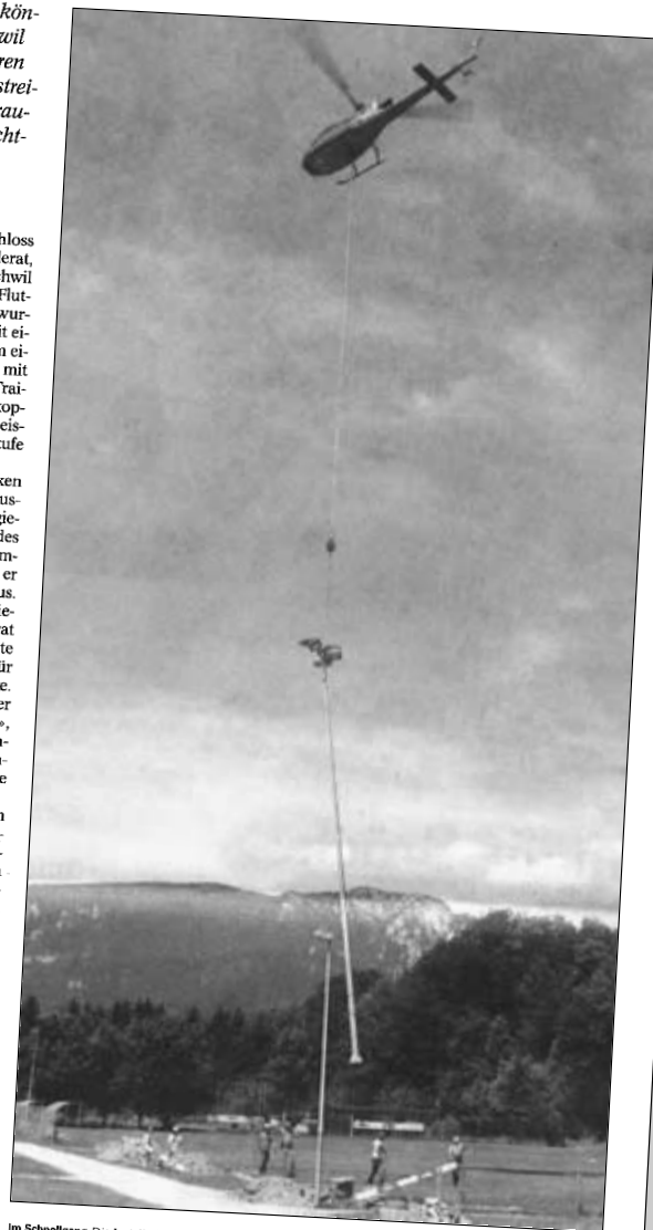
Im Schnellgang Die Installation der acht Flutlichtmasten per Helikopter dauerte bloss 20 Minuten.
